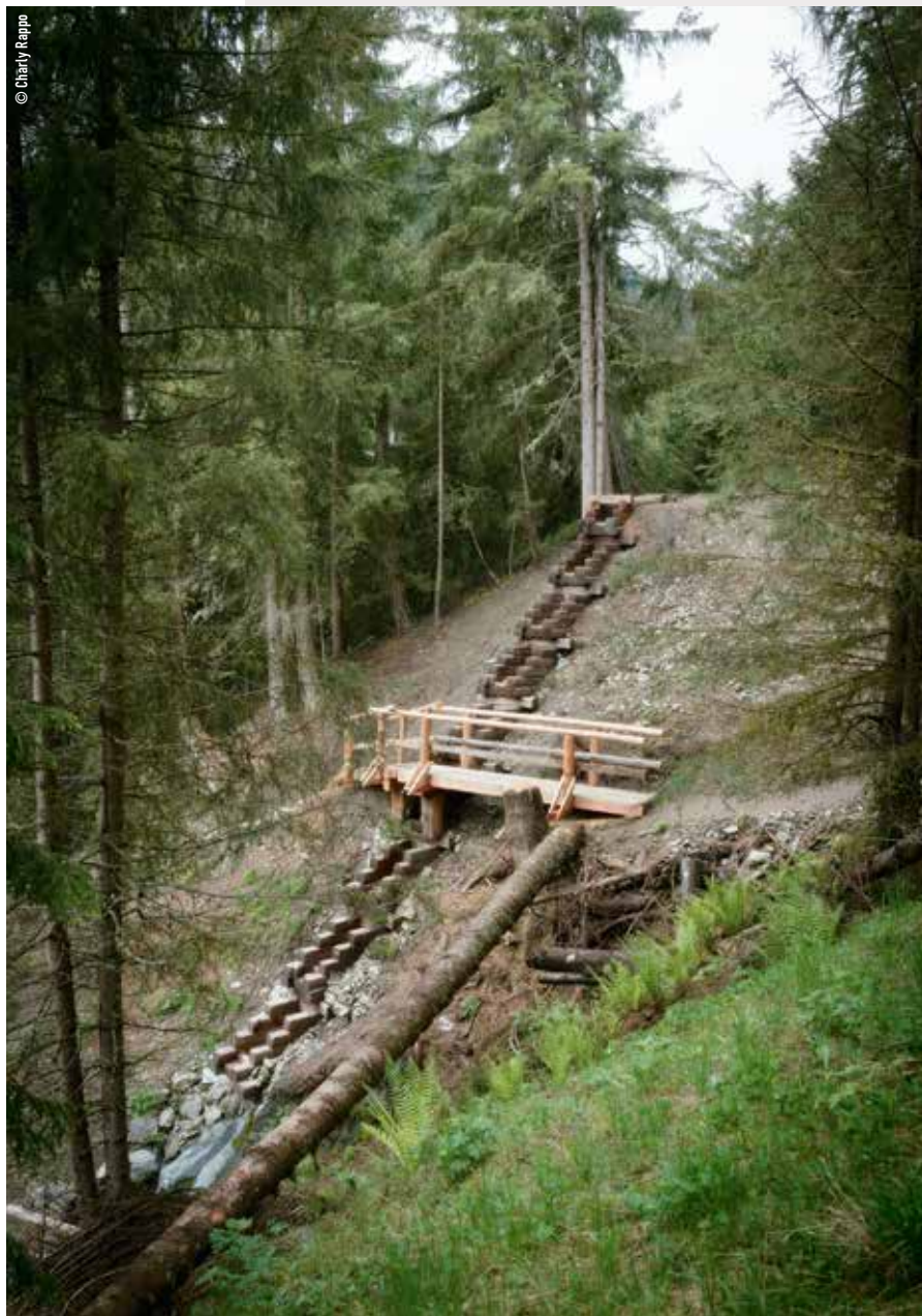
CASCADE EN BOIS, PREMIER TRONÇON VISIBLE APRÈS LA PRISE D'EAU DANS LE TORRENT DE VERSEGÈRES
