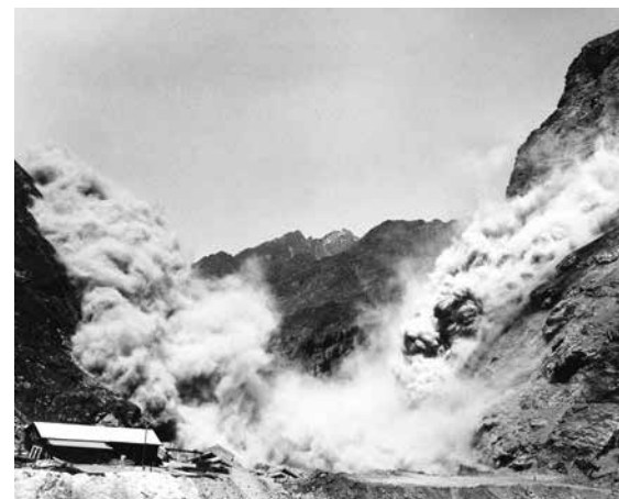
MINAGE LORS DE LA CONSTRUCTION DE MAUVOISIN
